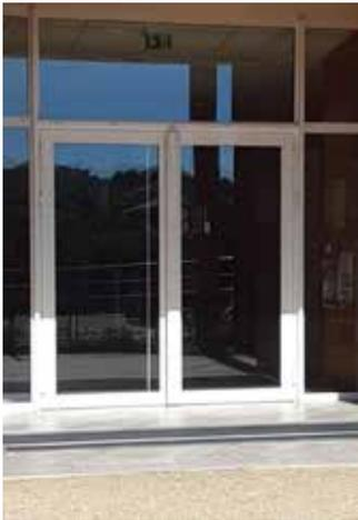
Une nouvelle porte d'entrée a été installée à l'école élémentaire Comtesse de Ségur, afin d'assurer la sécurité de tous et permettre l'ouverture de l'entrée depuis le bureau du directeur. Il s'agit d'une porte avec un déclencheur d'ouverture électrique et fonctionnant avec un visiophone. La pose a été réalisée par la
