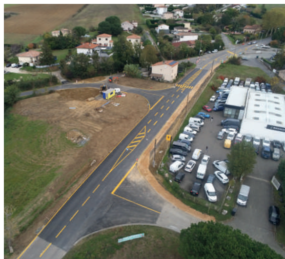
↑ Aménagement pendant les travaux
